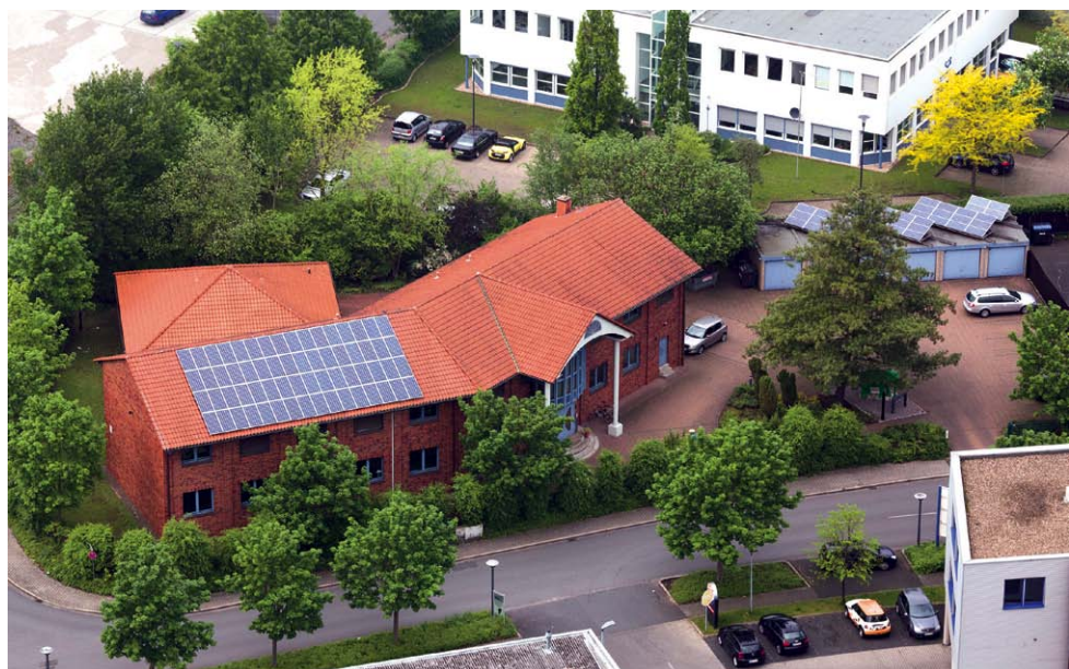
EKF Elektronik betreibt derzeit zwei Photovoltaikanlagen, auf dem Hauptgebäude und auf dem Garagengebäude. In diesem Jahr soll auf dem Nebengebäude eine weitere Anlage installiert werden.
